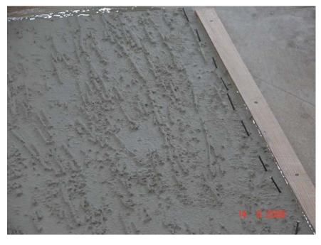
При использовании металлической опалубки, края матрицы фиксируются грузами. Поверхности используемых грузов не должны оказывать деформирующих воздействий на матрицу.
