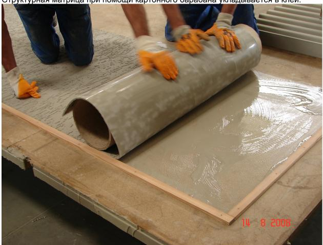
После этого, вторую половину матрицы поднимают и клей наносится на вторую половину опалубки.
