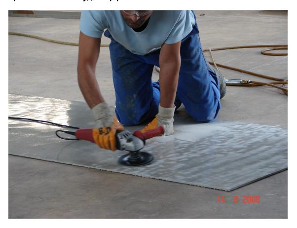
ВАЖНО: Допускается использование только шлифовальной машинки с низкими оборотами, поскольку шлифовальный инструмент, вращающийся с высокой скоростью, может приводить к местному перегреву эластомера.
