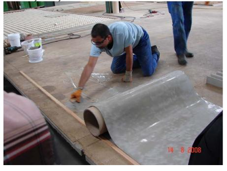
Затем, вторая половина матрицы укладывается в клей.
