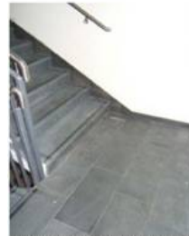
Foto 14. Detalj skiferfliser på trapp og sokkellist
