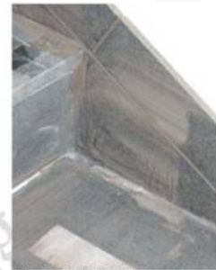
Foto 15. Detalj skiferfliser på trapp og sokkellist
